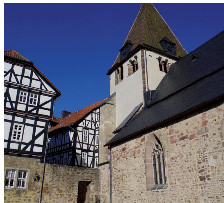
Westwerk nach der vollständigen Sanierung von Dach und Fassaden (Foto: RWS)
