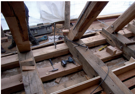
Detail Zimmerarbeiten zur Reparatur der Mauer-schwellen u. Deckenbalken (Foto: RWS)
