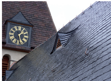
Schieferdachfläche mit eingebundener Deckung auf der Lüftungsgaube (Foto: RWS)
