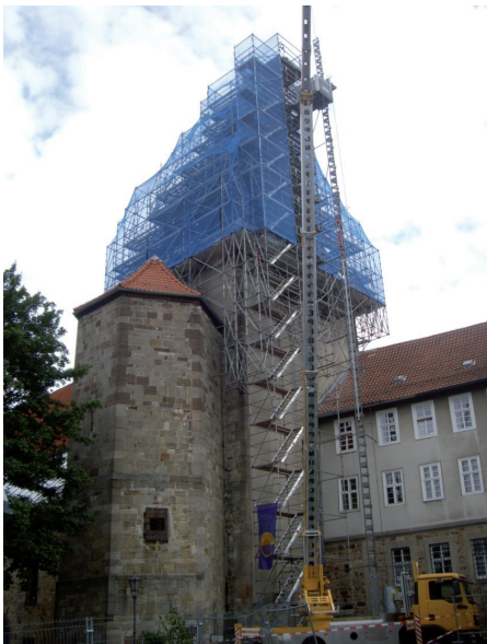
Ansicht Westwerk mit eingerüstetem Turmhelm (Foto: RWS)
