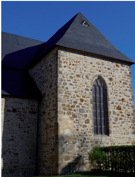
Ansicht südliches Querhaus mit neuer Verfugung und eingebundenen histor. Putzflächen (Foto: RWS)
