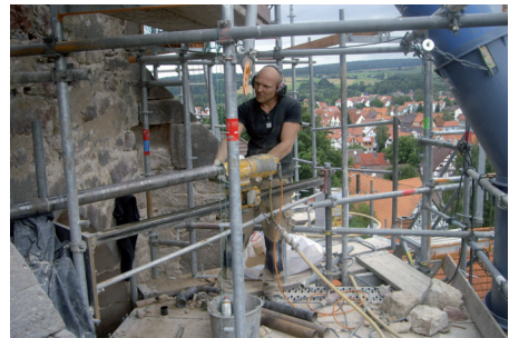
Anlegen der Bohrkanäle für die Verspannungen im Mauerwerk des Chores (Foto: RWS)
