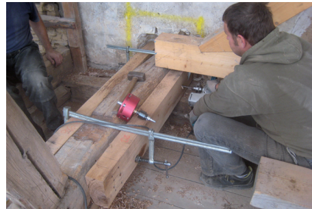
Sicherung der Dachkonstruktion über dem nördl. Seitenschiff (Foto: RWS)
