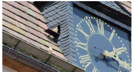
Turmfalkenpärchen vor dem neuen „Falkenhotel“ (Foto: Does)
