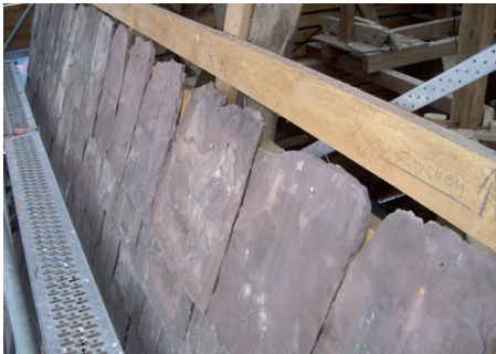
Innenansicht des Dachtragwerkes über dem Westwerk (Foto: Does)
