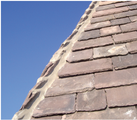
Dachdeckung des Westwerkes mit Sandsteinplatten (Foto: RWS)
