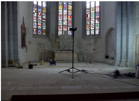
Chorraum mit den neu verlegten Sandsteinplatten (Foto: RWS)
