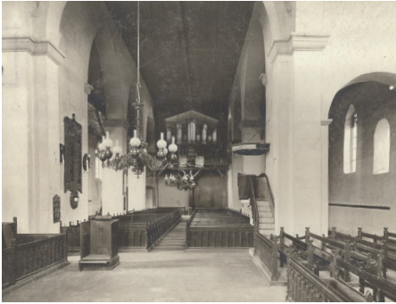
Innenaufnahme, Blick nach Westen zwischen 1874 und 1935 (Foto: Archiv LfDH Marburg)
