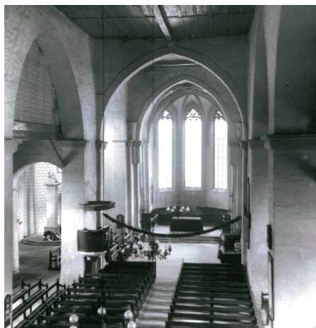
Innenaufnahme, Blick nach Osten mit Ehrenmal zwischen 1921 und 1935 (Foto: Archiv LfDH Marburg)
