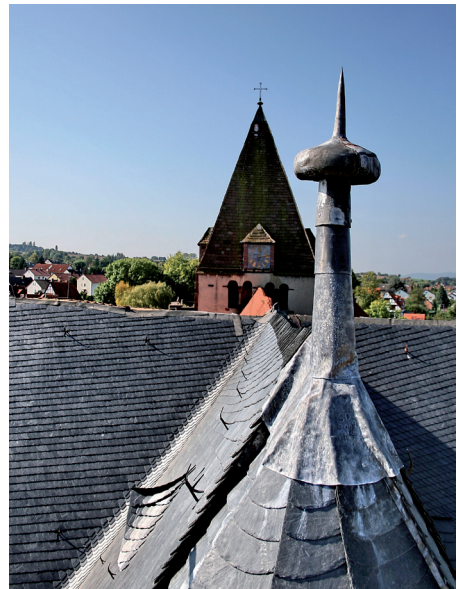
Die wiedermontierte Zwiebel auf dem Dach des Chorschlusses (Foto: Does)
