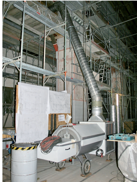
Heizgebläse und Installationen zur Wärmebehandlung der Unterzüge (Foto: Does)
