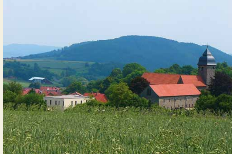
Blick auf die Klosteranlage Germerode, links das neue Konventsgebäude der Communität Koinonia
