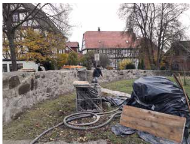
Sanierung der Kirchenmauer in Baunatal-Großenritte
