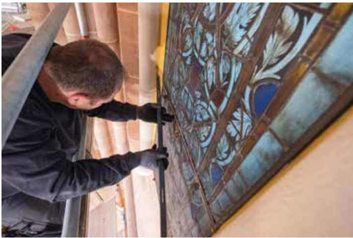
Lisa Körner und Sascha Loßmann von der Taunussteiner Firma Glasstudio Derix beim Herauslösen der mittelalterlichen Fenster in Marburg
