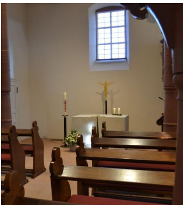
Frisch sanierter Innenraum der Laurentiuskirche in Hain-Gründau
